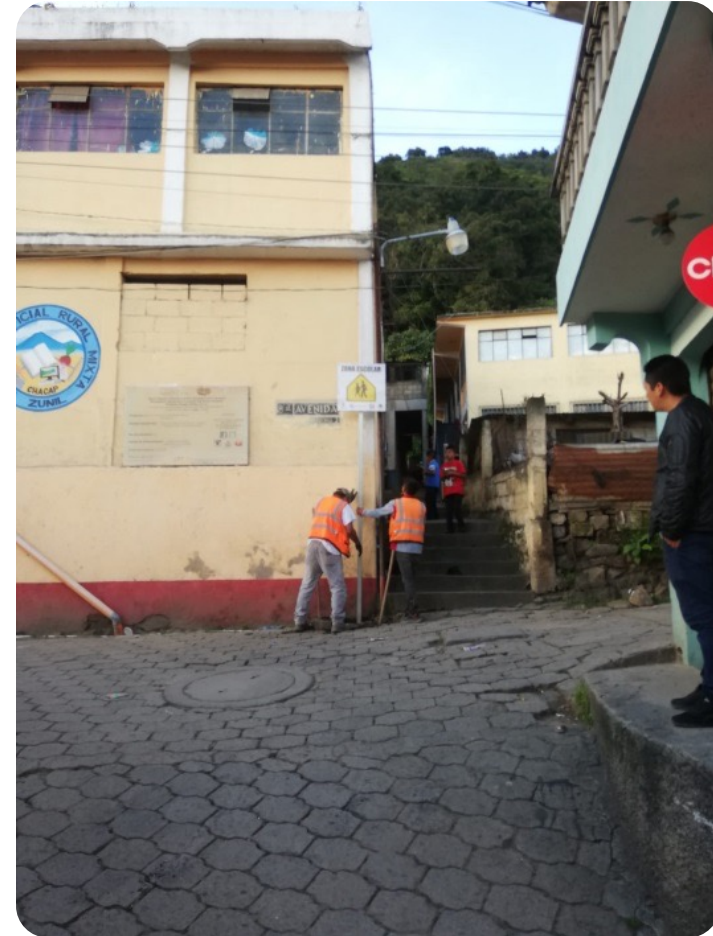
Instalación de 2 señalizaciones en la Escuela Oficial Rural Mixta Cantón Chacac
